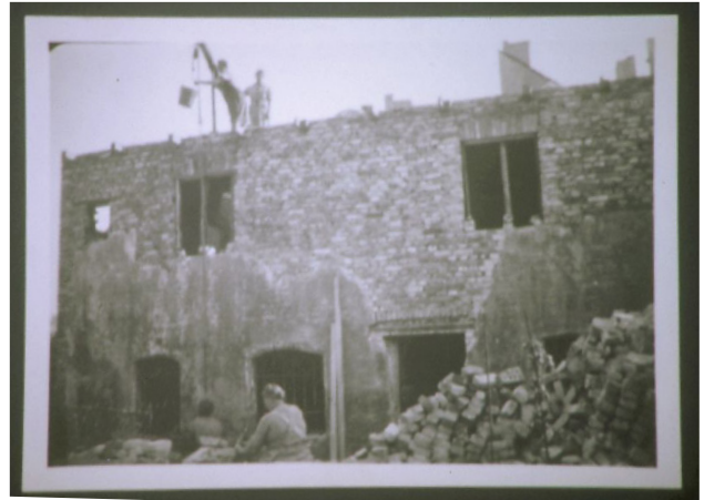
Errichtung des Behelfshauses nach dem 2. WK.
